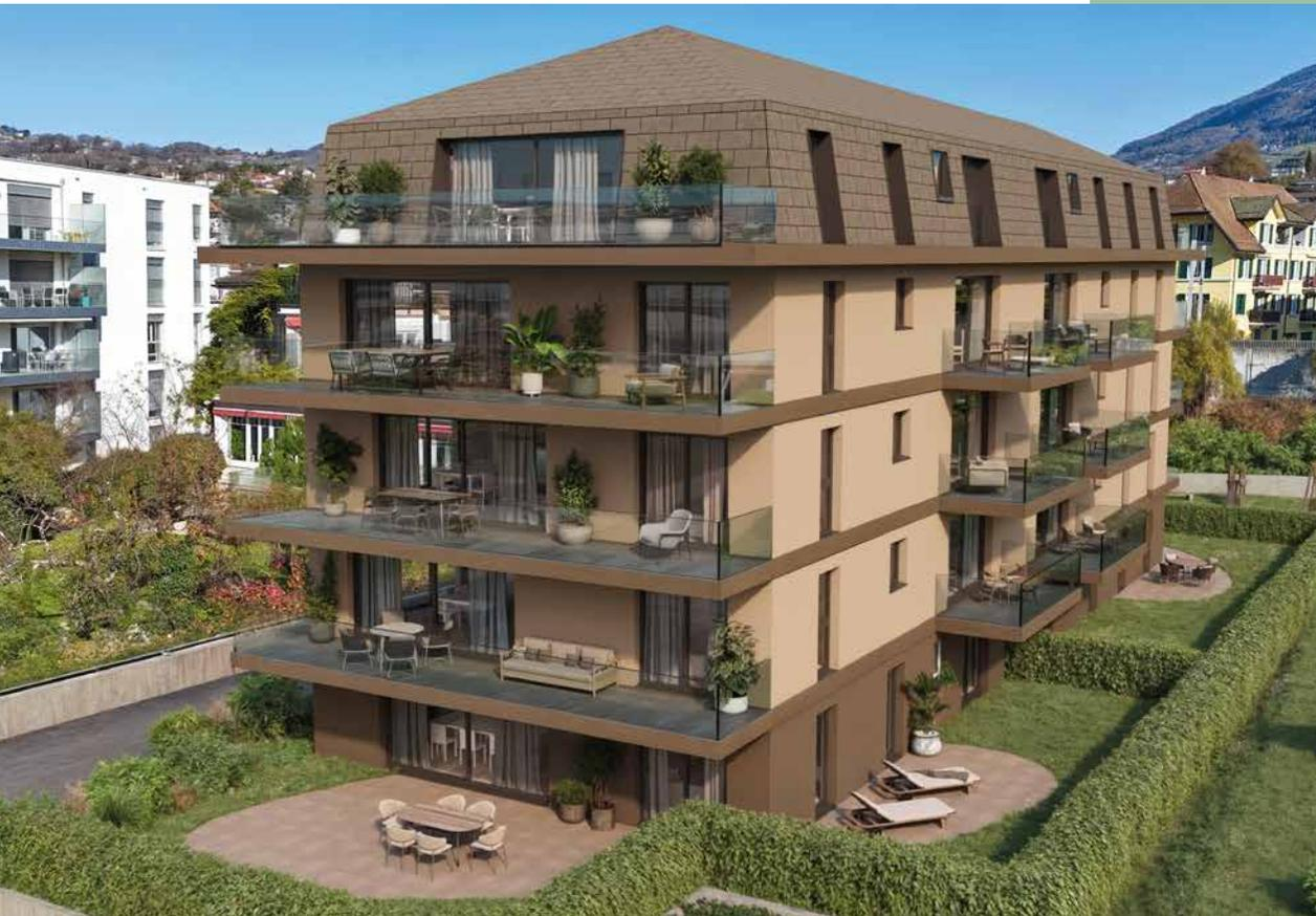
Cet immeuble construit en maçonnerie traditionnelle répondra aux normes des bâtiments à faible consommation d'énergie et sera doté d'une toiture à mansarde avec panneaux photovoltaïques.
